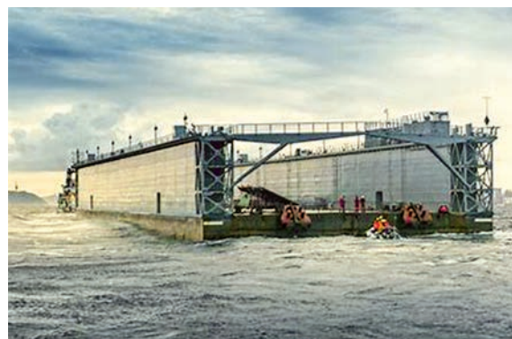
Залізобетонний плавучий док, привальний брус зовнішнього борта, захищений ППМ від дії соляного туману та морської води
