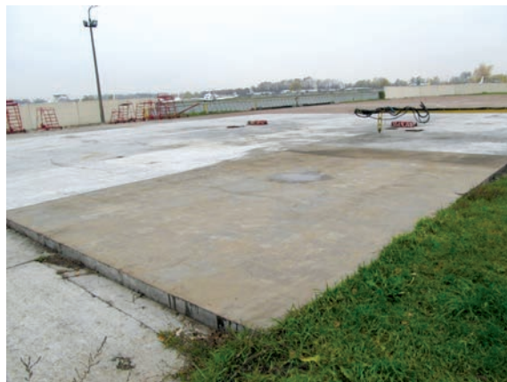
Бетонний майданчик для відстою літака, захищений поліфункціональним поліуретановим матеріалом (ППМ)
