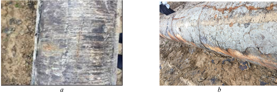
Рис. 1. Деградація ізоляційного покриття (а) та корозійні ураження металу (b) МГ "Пасічна-Тисмениця".
