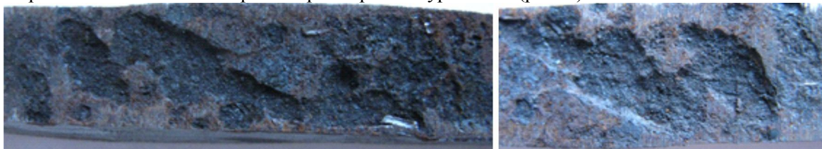
Рис. 1. Внутрішня поверхня експлуатованої труби викидної лінії свердловини.
